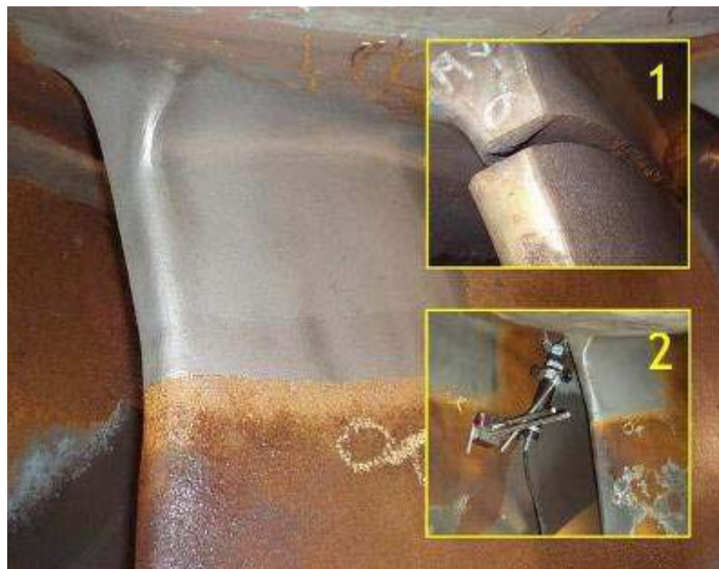
Fig. 4: Procedimento de solda de reparo aplicado para recuperação da pá de uma turbina hidroelétrica com trinca ao lado da coroa. Medição das tensões utilizando equipamento portátil de difração de raios-X RAYSTRESS para avaliação da eficiência do tratamento por shot peening. Foto: Tetyana Gurova
