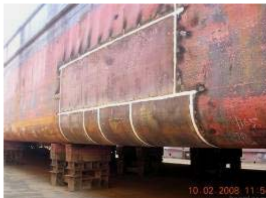
Fig. 2: Solda de reparo realizada no casco de navio durante trabalhos de manutenção (Foto: Internet)
